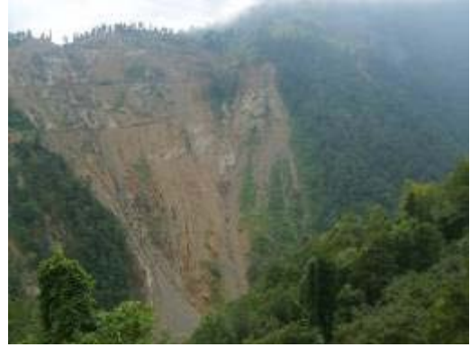
Şekil 4. Nehir tipi hidroelektrik santralının inşası sırasında cebri boru geçişi için açılan yol güzergâhından ve tünellerden çıkan toprak ve kaya parçalarının dere yatağına bırakılması (Orijinal)
