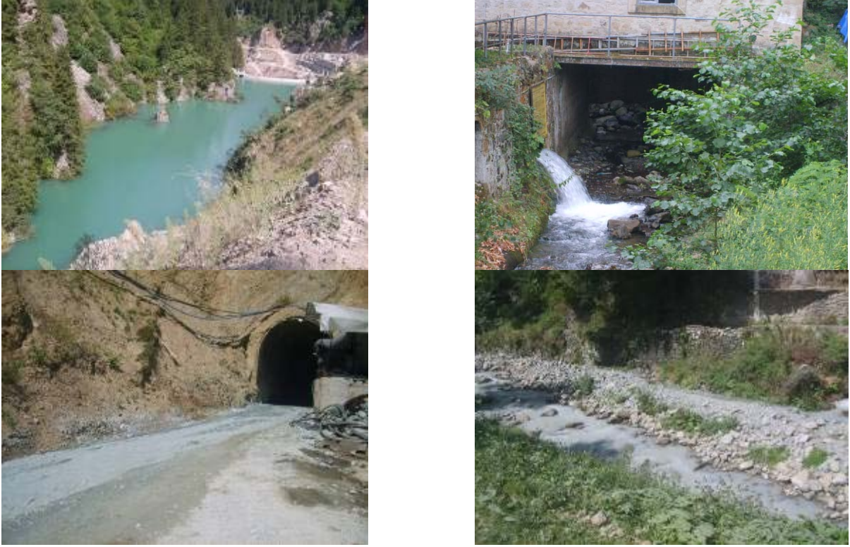
Şekil 3. Nehir tipi hidroelektrik santrallerinde a- regülatörde suyun tutulması, b- kuyruk suyunun dere yatağına bırakılması, c ve d- tünelden çıkan bulanık suyun dinlendirilmeden dere yatağına bırakılması (Orijinal)
