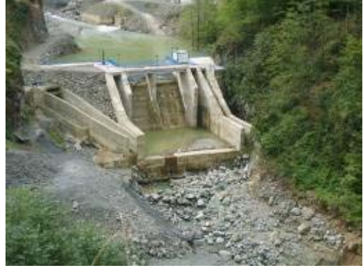
Şekil 5. Dere yatağına ve balık geçidine yeterli miktarda bırakılmayan telafi suyu (Orijinal)
