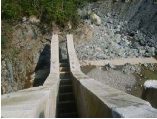
Şekil 5. Dere yatağına ve balık geçidine yeterli miktarda bırakılmayan telafi suyu (Orijinal)
