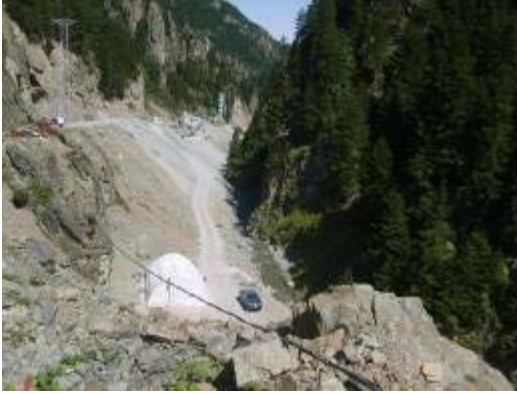
Şekil 4. Nehir tipi hidroelektrik santralının inşası sırasında cebri boru geçişi için açılan yol güzergâhından ve tünellerden çıkan toprak ve kaya parçalarının dere yatağına bırakılması (Orijinal)
